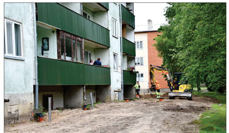
Pašlaik Piltenē, Lauku ielā, notiek sadzīves un lietus ūdens kanalizācijas tīklu izbūve. To veic SIA “Green Amber”, darbu vadītājs Dzintars Gruntmanis, būvuzraudzība uzticēta SIA “BŪŪZ” darbiniekiem. Līguma summa 180 383,25 eiro. IEVAS MUCENIECES FOTO
