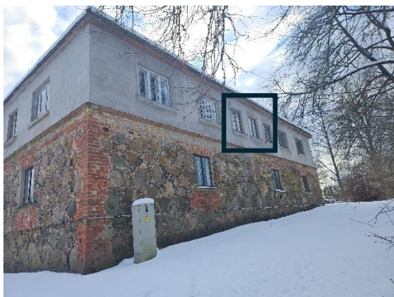
Ēkas fasāde ar dzīvokļa logiem
