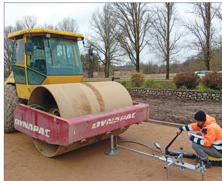
Ugālē pašvaldība realizē investīciju projektu, atjaunojot ceļa brauktuves segumu un izveidojot autostāvvietas.
