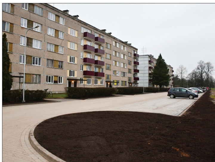
Pie Rūpnīcas ielas 11 izveidota autostāvvietā aptuveni 50 automašīnām.
