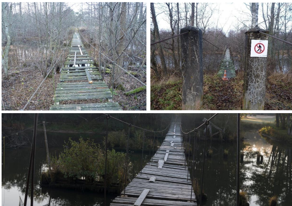
Attēls Nr. 4. Gājēju tilts pār Irbes upi
