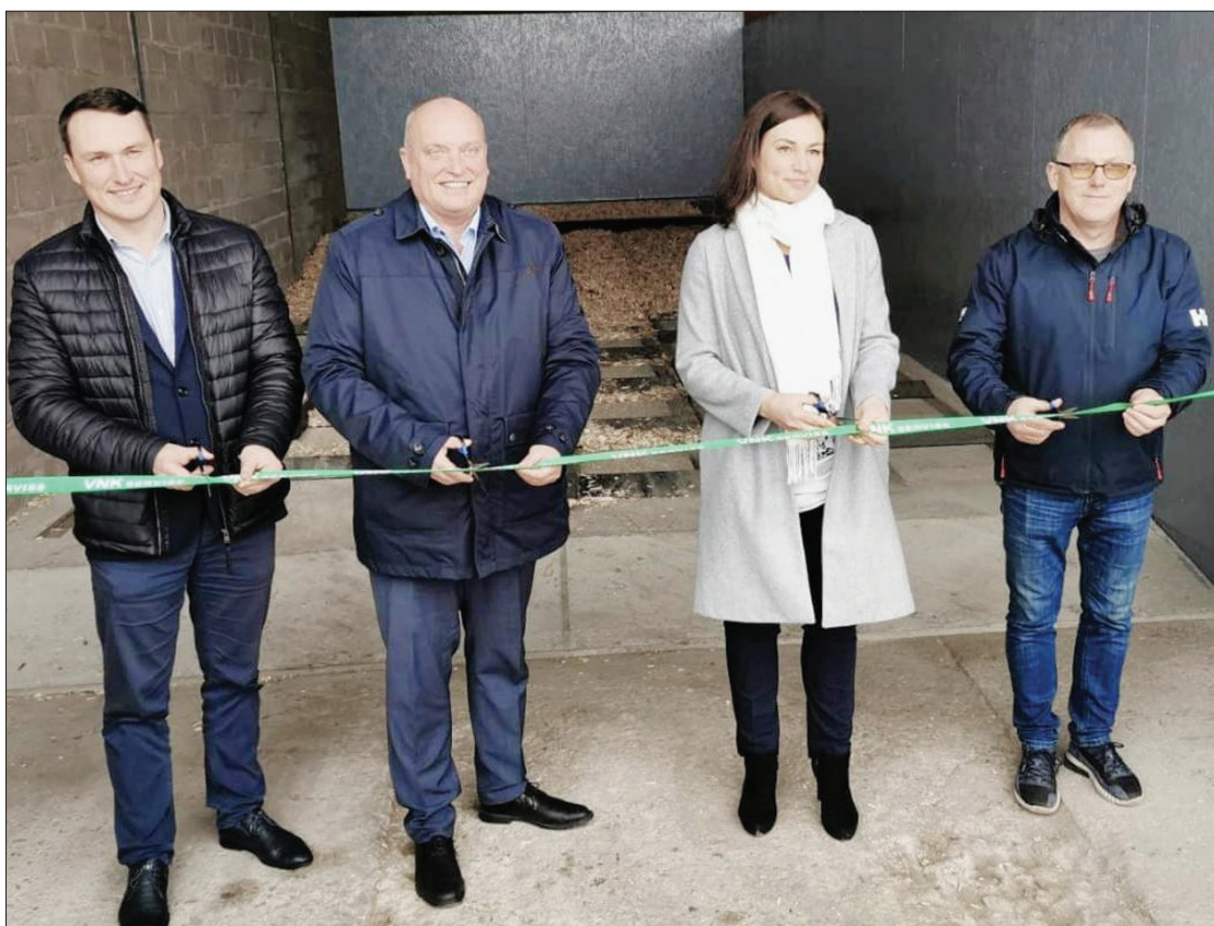
Svinīgs brīdis – atklāta modernizētā katlumāja Jūrkalnē. DIĀNAS SKUDRAS ARHĪVA FOTO
