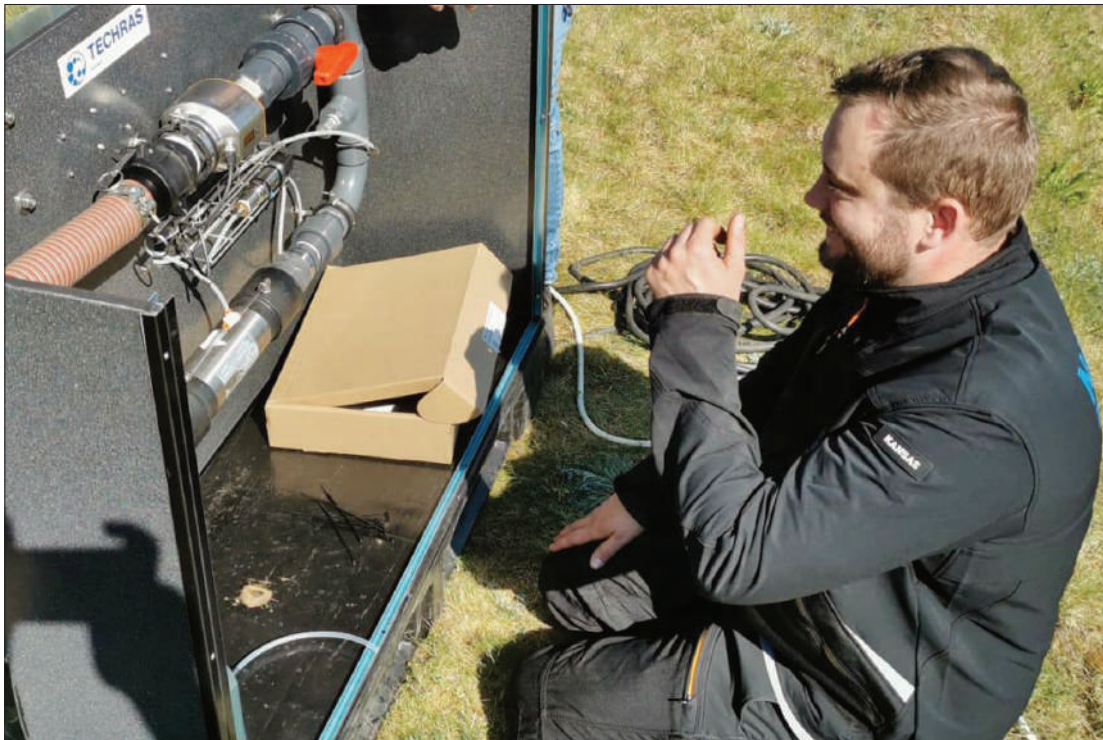
Mikroburbuļu iekārtas uzstādīšana Jūrkalnē. SIA “VNK serviss” ARHĪVA FOTO
